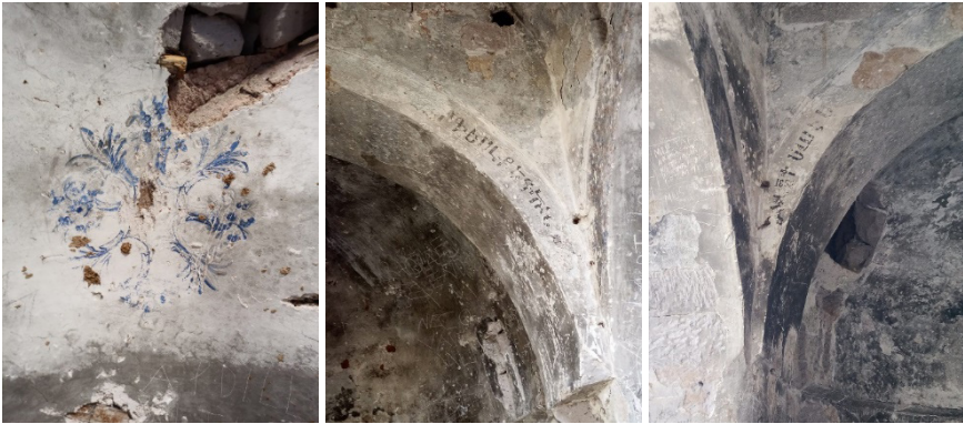
Resim 6. İç mekanda bulunan duvar resimlerinin izleri
