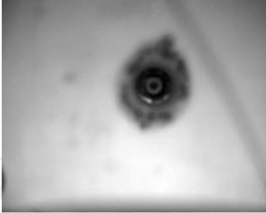
Şekil 6.4. İstikamet dūmeninin sol yüzünde bulunan, 3 numaralı askı noktasında ki suyun termal kamera ile görüntülenmesi
