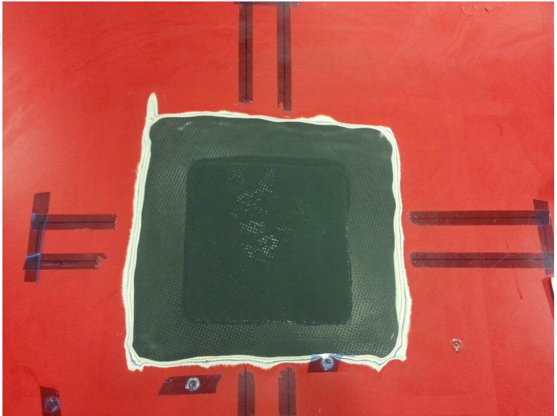
Şekil 6.18. Tamir bölgesinin üzerine son iki kat cam fiberlerin yerleştirilmesi sonrasındaki görünümü
